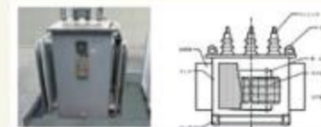
高圧変圧器の例
