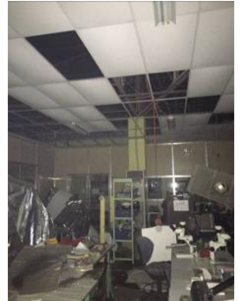
■天井パーテーション落下
