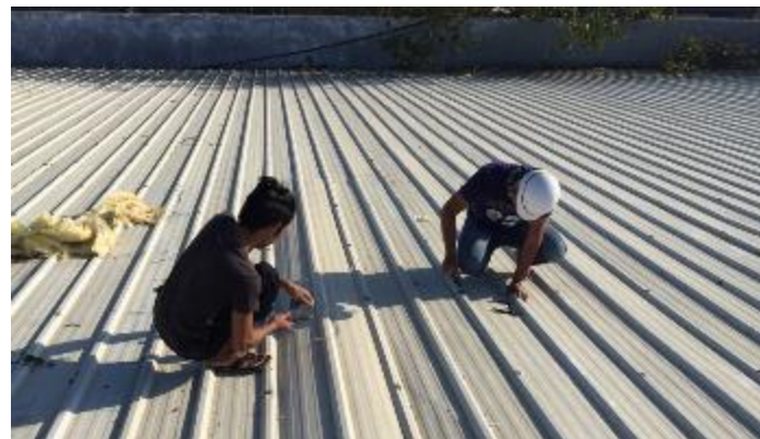
■ 建屋屋根修繕中
