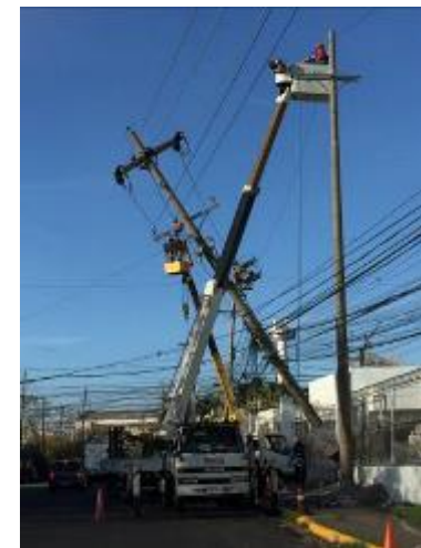
■インフラの復旧が急ピッチで行われる
