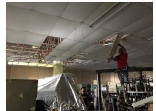
■ 天井パーテーション修繕
